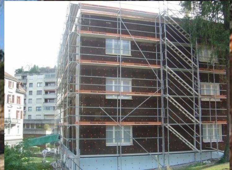
Isolamento de parede exterior
