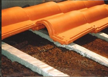
Isolamento de sótãos
