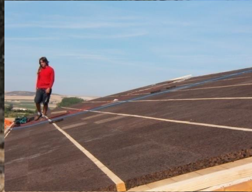
Isolamento de telhado
