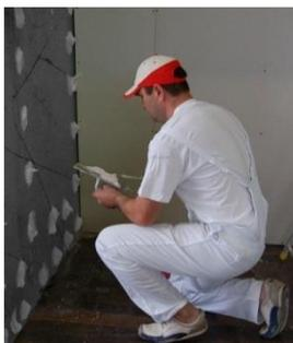
Aplicar os pontos de cola afastados 40 cm, reforçando no perímetro de cada placa. A cola pode ser aplicada na placa ou diretamente na parede.
