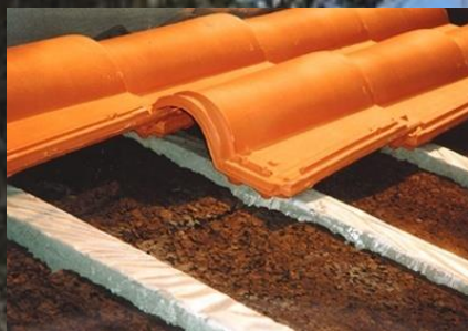
Isolamento de sótãos
