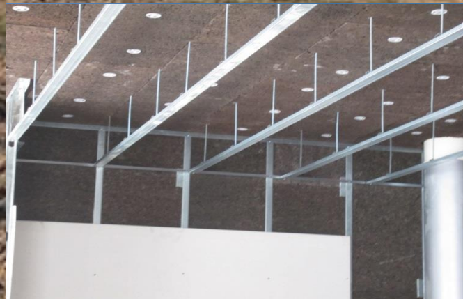
Revestimentos interior – placa de gesso
