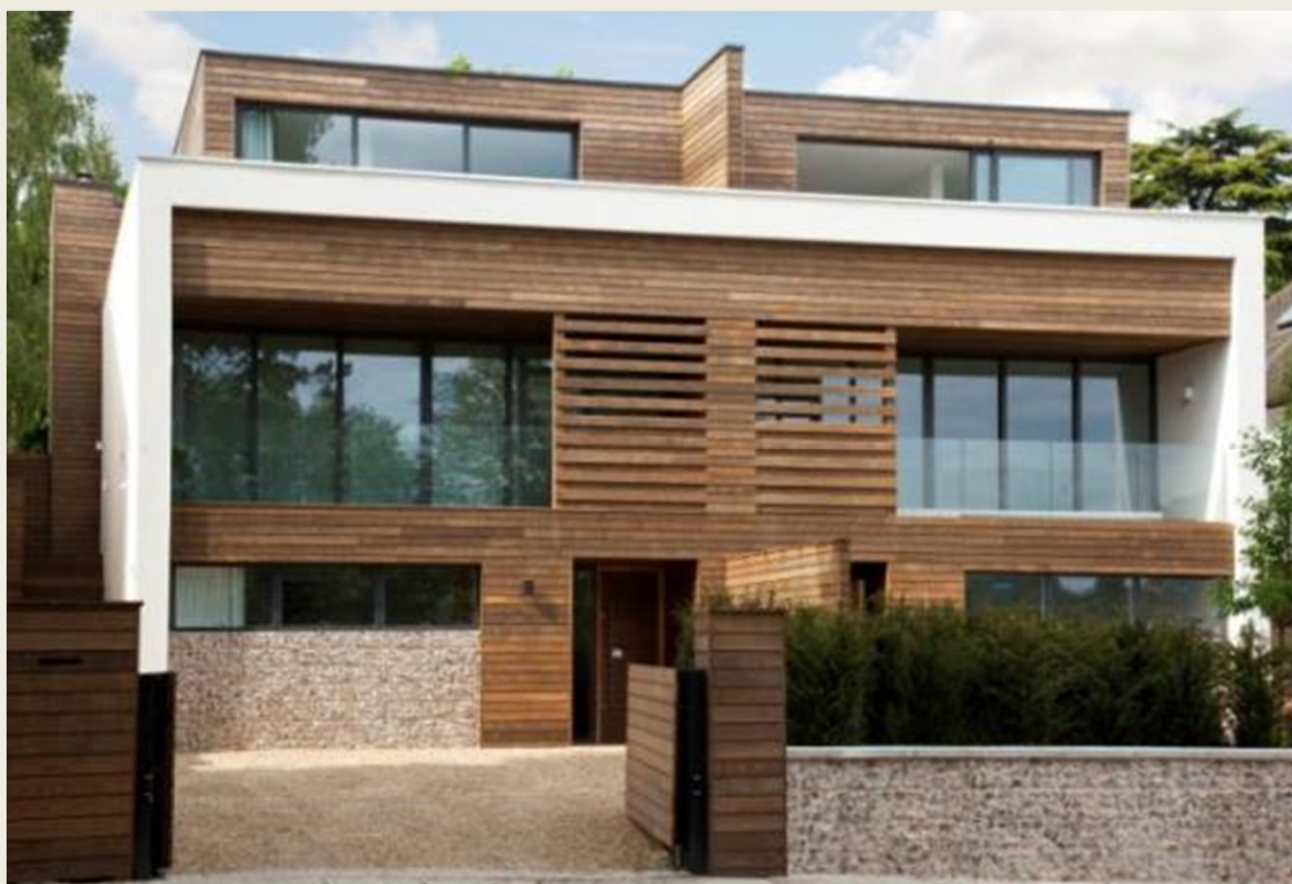
MORADIA EM HURST AVENUE, LONDRES (INGLATERRA)
