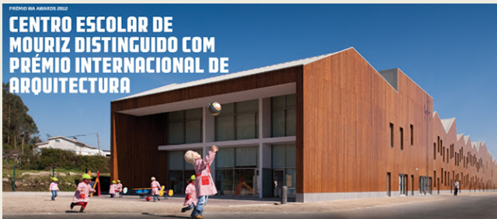
CENTRO ESCOLAR DE MOURIZ, PAREDES (PORTUGAL)
