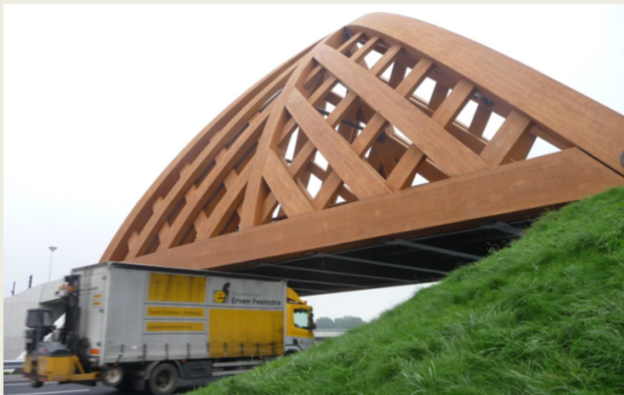
PONTE DE MADEIRA DO MUNDO DE TRAFICO PARA PESADOS (60 TON), SNEEK (HOLANDA)
