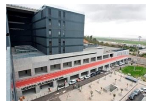
Novo Hospital de Vila Franca
