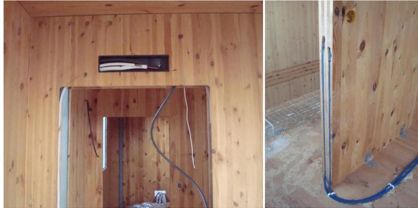
Rasgos perpendiculares à direcção principal de flexão só possíveis juntos aos apoios
