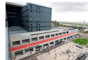
Novo Hospital de Vila Franca
