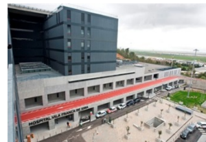
Novo Hospital de Vila Franca
