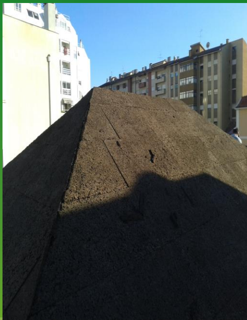
COBERTURA INCLINADA COM SUBTELHA
