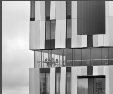
Cassete Suspensa estruturação de fachada vertical
