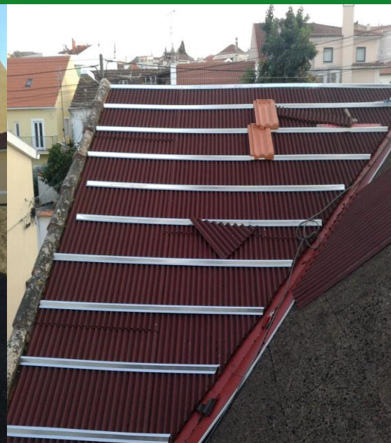
COBERTURA INCLINADA COM SUBTELHA
