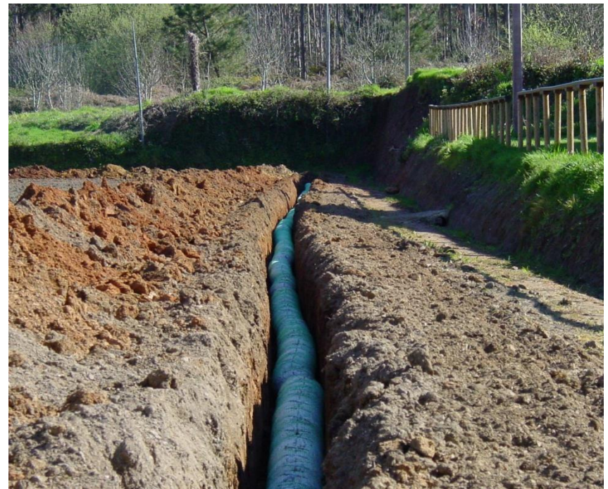
VALA DE DRENAGEM COM DRENOTUBE
