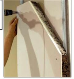
**4 paredes duplas** – Isolante térmico preenchendo completamente a caixa-de-ar
