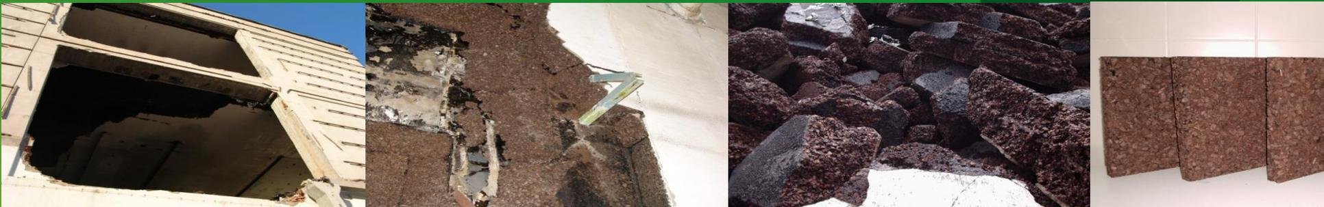
Cortiça de isolamento utilizada para isolamento de um LOCAL DE ARMAZENAMENTO FRIO, construído em 1964 e demolido em 2009 por questões imobiliárias.
