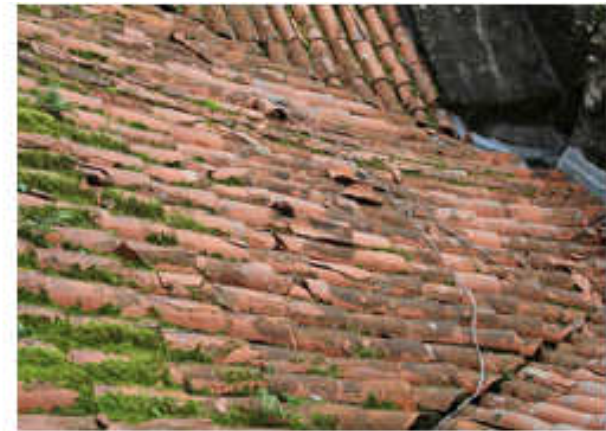
Degradação por ação do gelo.
