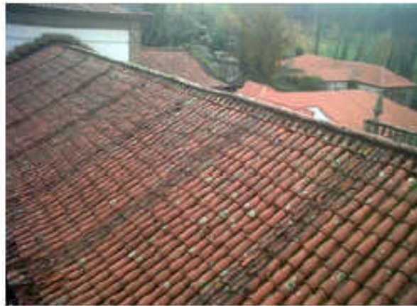
Pendente com rebentamentos.
