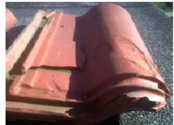
Degradação por ação do gelo.
