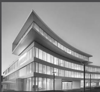
Cassete SZ20 estruturação de fachada horizontal
