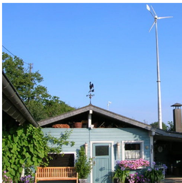
FIGURA 54 ● Exemplo de pequena turbina eólica
