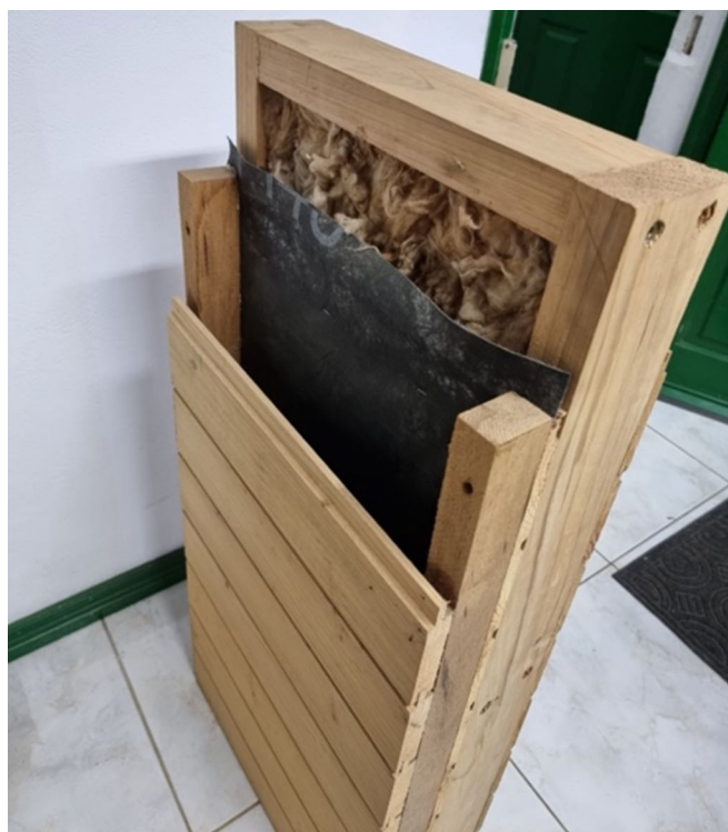
FIGURA 33 • Exemplo de parede pré-fabricada em madeira de criptoméria com isolamento em la mineral
