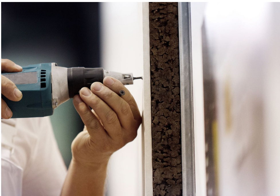
FIGURA 24 ● Fixação da placa Gypcork®
