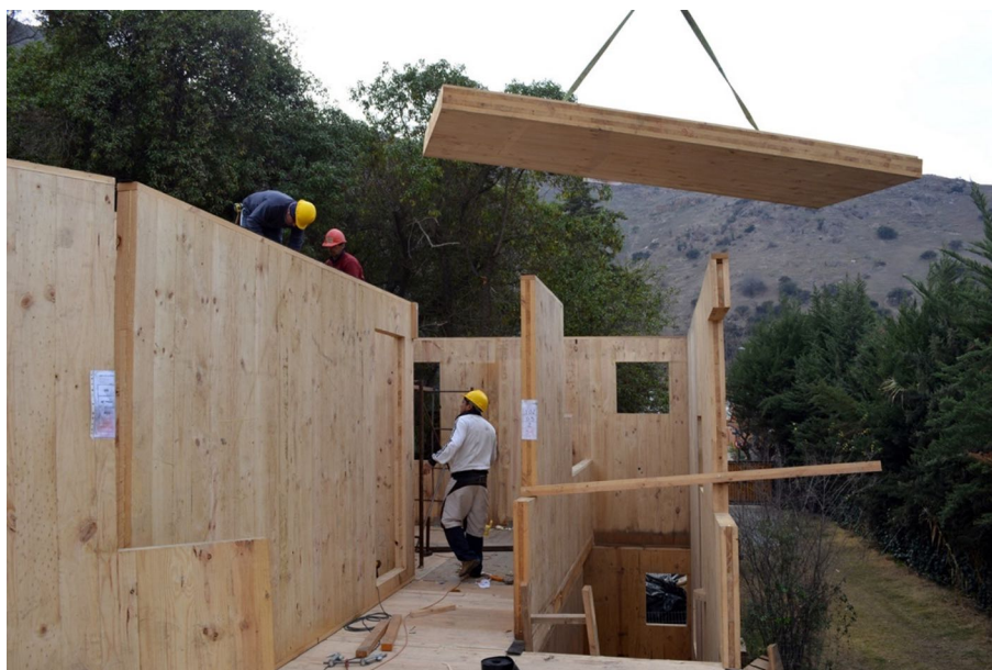
FIGURA 31 • Paredes estruturais em CLT
