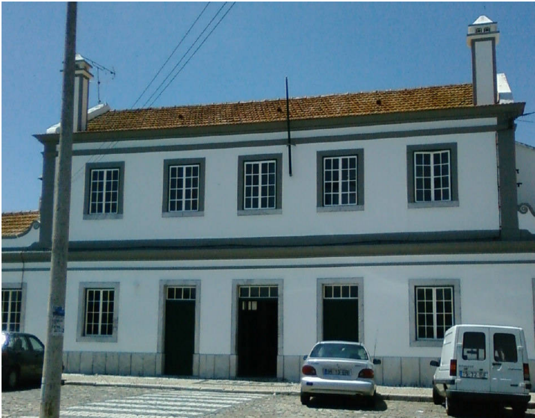
Fig. 3.3. Exemplo de fachada com recurso a ganho directo, na estação de Cuba, Alentejo
