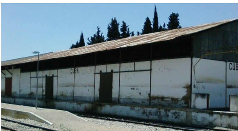
Figura 3.6. Cais coberto da Estação de Cuba
