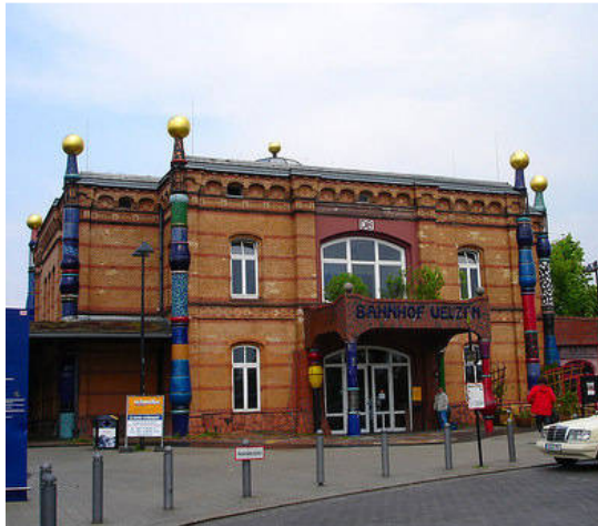
Fig.3.15. Estação ferroviária – Uelzen, Alemanha
