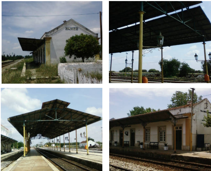
Fig. 3.4. Exemplos de dispositivos de sombreamento e de de protecção às chuvas nas estações
