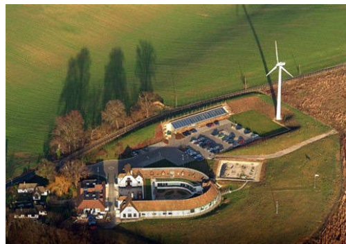
Fig.3.17. Escritórios de Renewable Energy Systems , 2003
