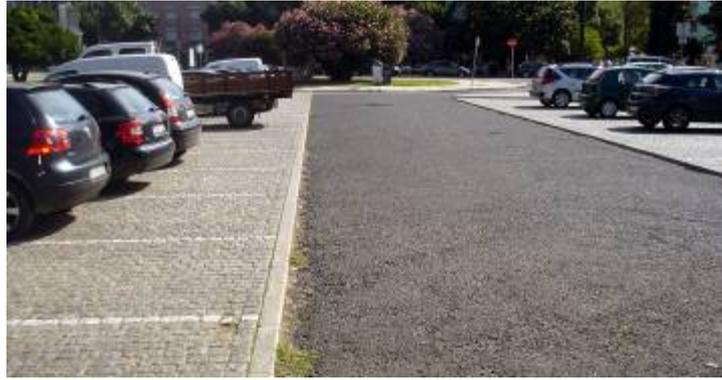
Fig. 89 – Pavimento semi-drenante no estacionamento
