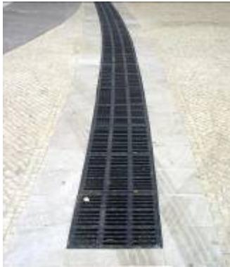
Fig. 101 – Caleira para recolha das águas pluviais
