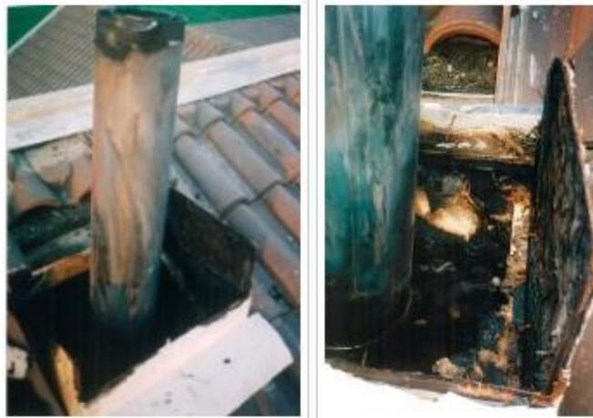
Fig.5.24 – Consequência de incêndio causado em chaminé de conduta metálica [65]
