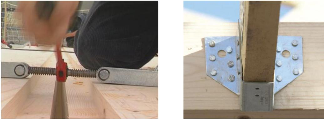
Fig.5.13 – Ligação entre painéis [22] e armadura portante [23]
