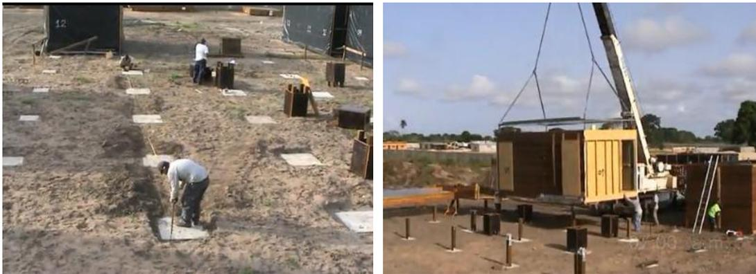
Fig.2.16 – Implantação dos apoios para sobrelevação e Colocação do módulo em obra [23]
