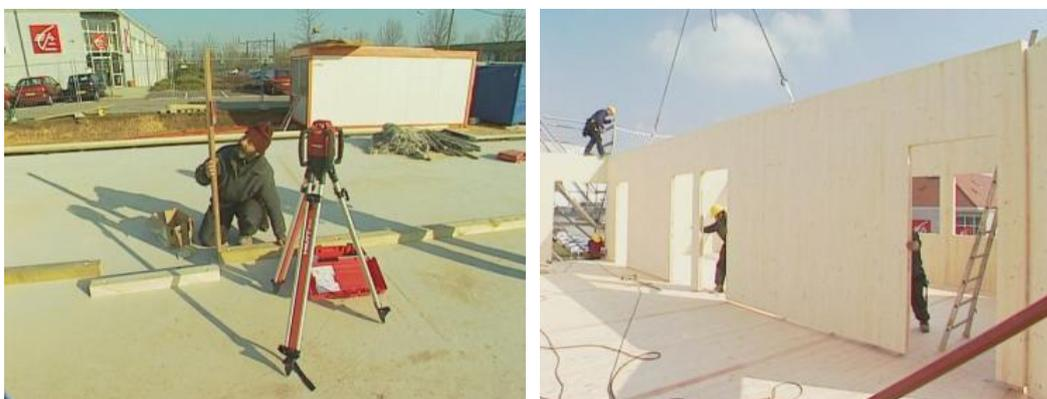
Fig.2.15 – Implantação da 1ª fiada e Colocação de um módulo em obra [22]
