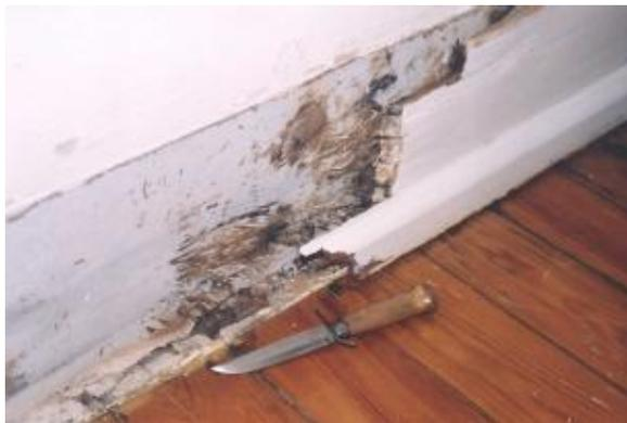
Fig.3.5 – Degradação do rodapé por acção de fungos [7]
