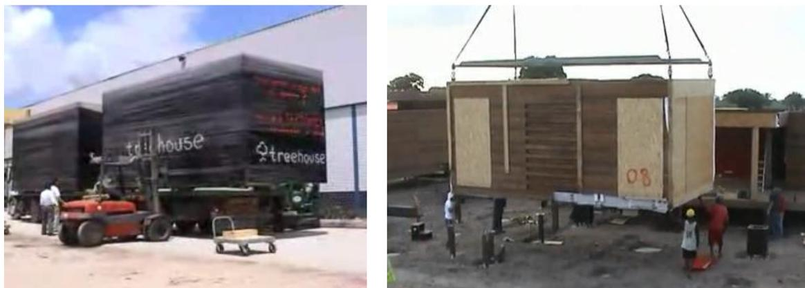
Fig.4.4 – Colocação dos módulos em camiões para transporte e Implantação do módulo com recurso a grua [23]
