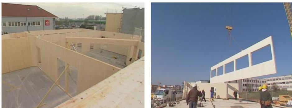
Fig.4.9 – Colocação das paredes prefabricadas em obra [22]
