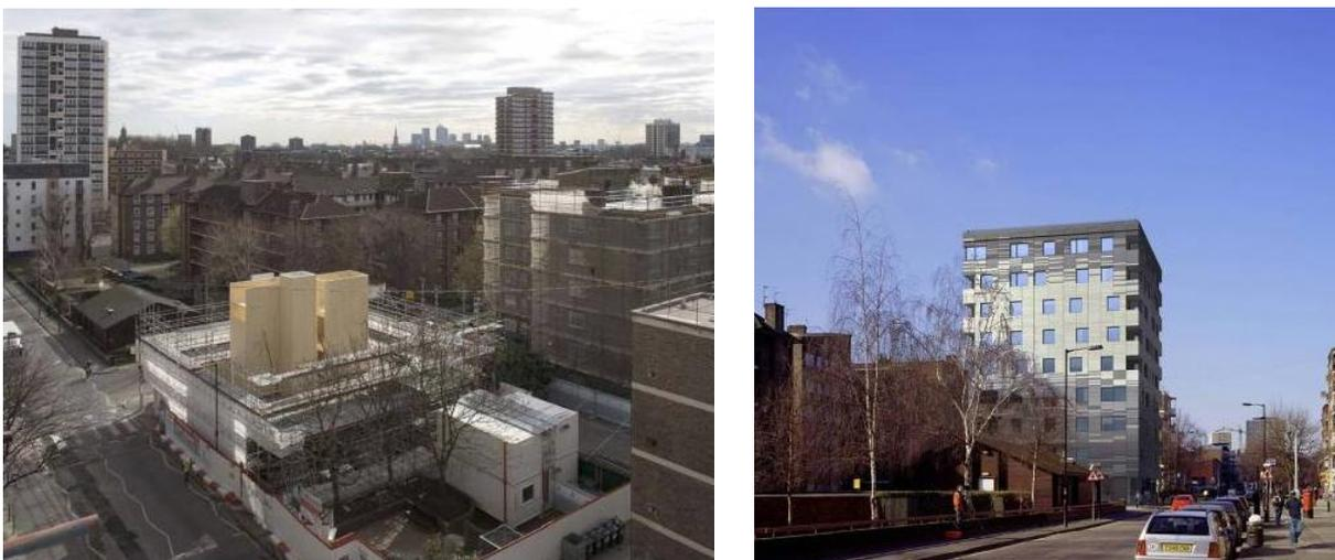
Fig.4.12 – Construção do edifício Murray Grove, com destaque para caixa de elevador e caixa de escadas, e aspecto final [22]
