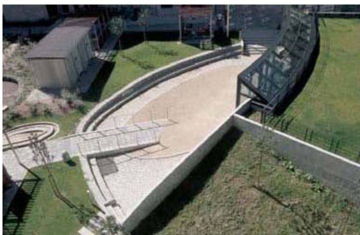
Fig. 43 Espaços verdes no interior do quarteirão Hedebygade Fonte: http://www.lille-metropole-2015.org
