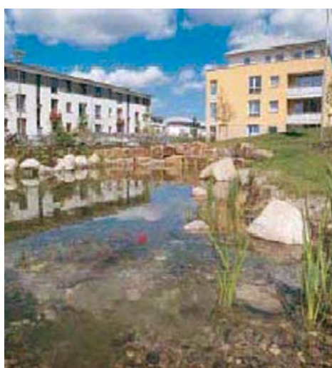
Fig. 28 Vista de uma bacia de retenção do sistema de águas pluviais. Fonte: http://www.hannover.de
