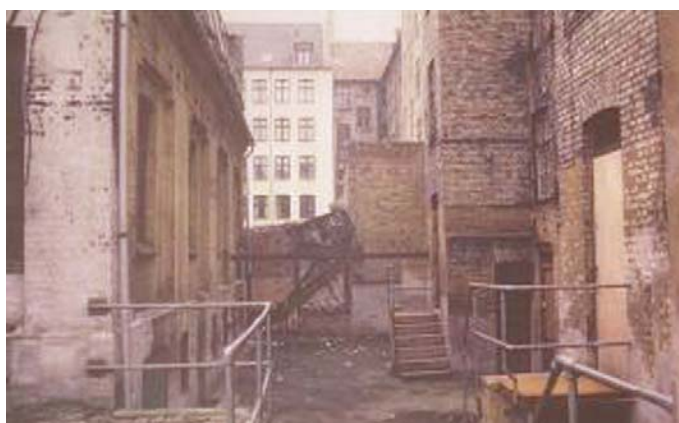
Fig. 40 Interior dos quarteirões (antes da intervenção) Fonte: http://www.lille-metropole-2015.org
