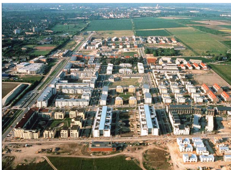
Fig. 27 Vista aérea do bairro de Kronsberg Fonte: http://www.hannover.de
