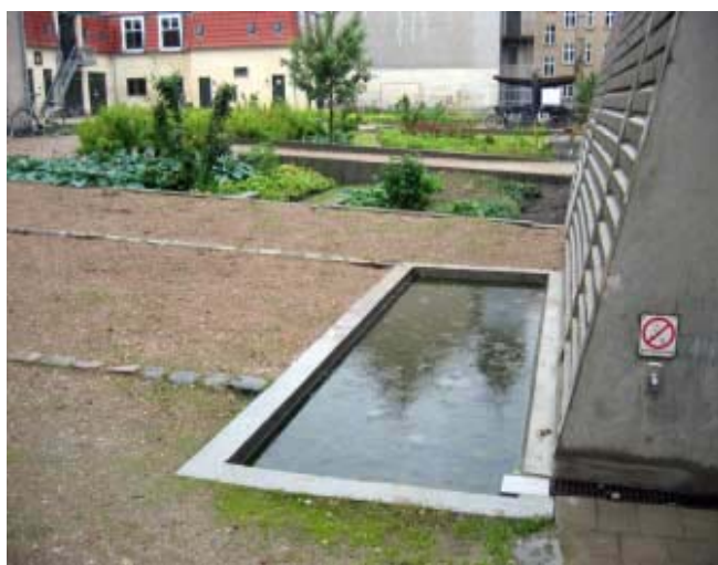
Fig. 37 Tanques para depósito de água da chuva Fonte: http://www.lille-metropole-2015.org
