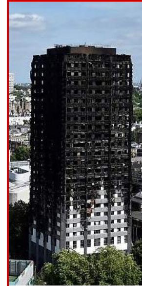
Torre Grenfell, Londres (2017)
