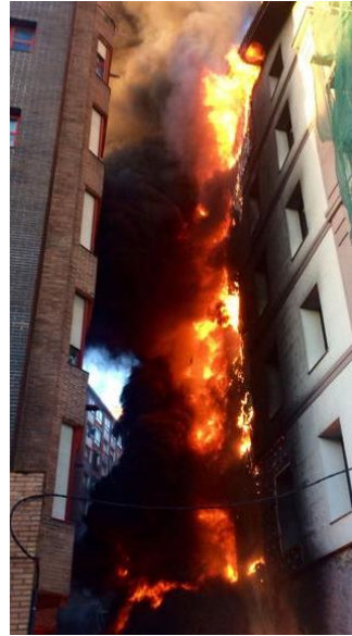
Edificio en obras, Sestao (2016)
