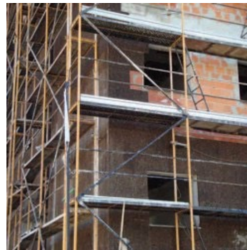
Edifício habitacional Santarém
