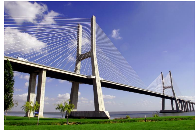
Ponte Vasco da Gama Obras de arte
