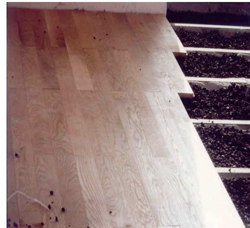
Enchimento de caixas de soalho
