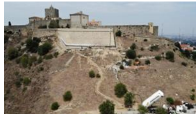
Consolidação Encosta Castelo Medieval Palmela
