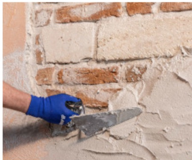
Regularização e reconstrução dos rebocos
