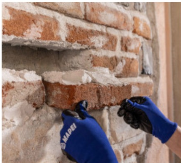
Reconstrução da alvenaria em tijolo
