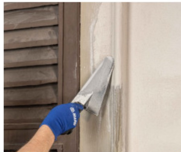
Reconstrução de elementos construtivos
