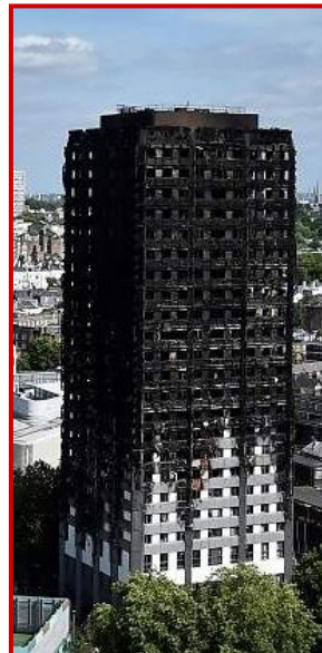
Torre Grenfell, Londres (2017)
