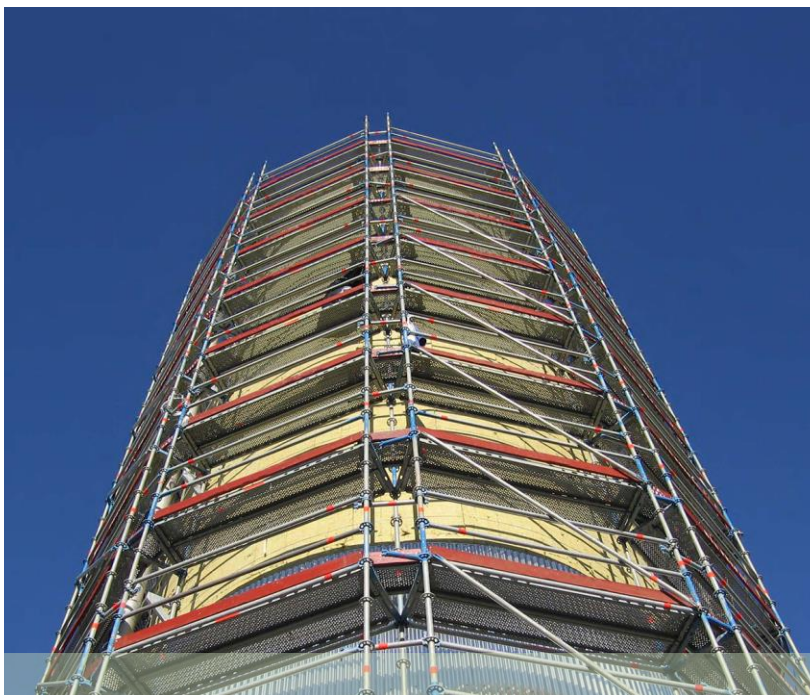
Isolamento de tanques / reservatórios
