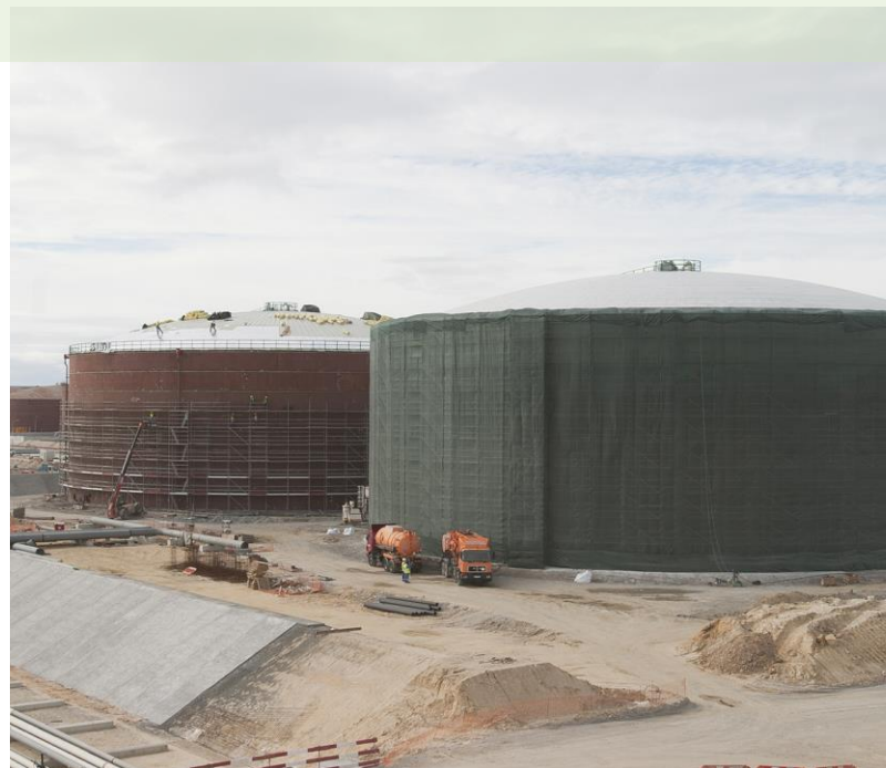
Isolamento de tanques / reservatórios
