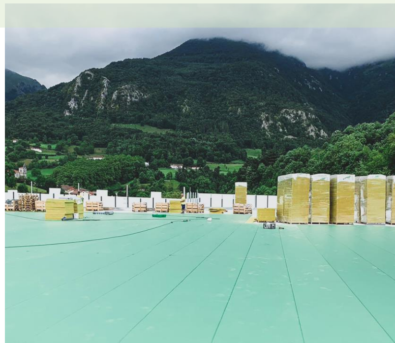
Nave Industrial, Espanha
