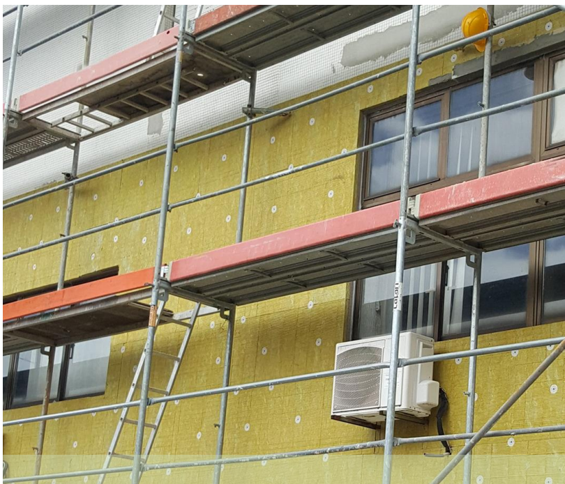
Edifício multifamiliar, Portugal
