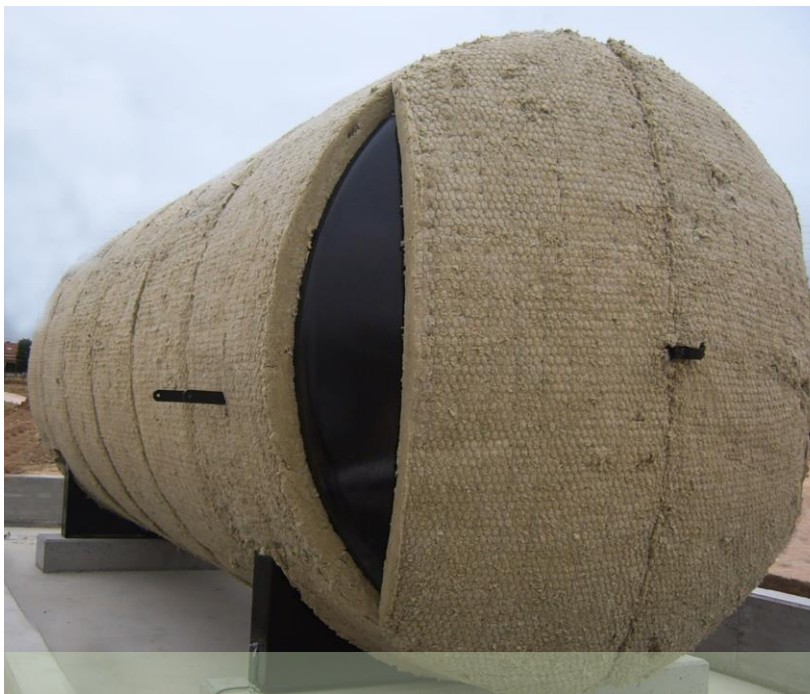
Isolamento de superfícies curvas
