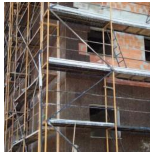
Edifício habitacional Santarém
