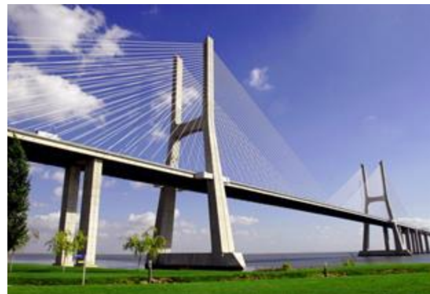
Ponte Vasco da Gama Obras de arte
