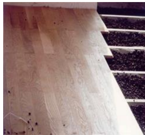
Enchimento de caixas de soalho
