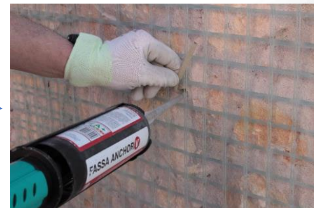
Fixação da primeira porção
