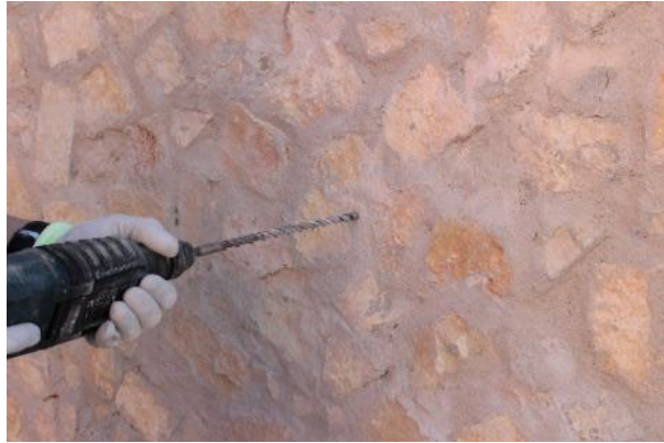
Execução dos furos no suporte
