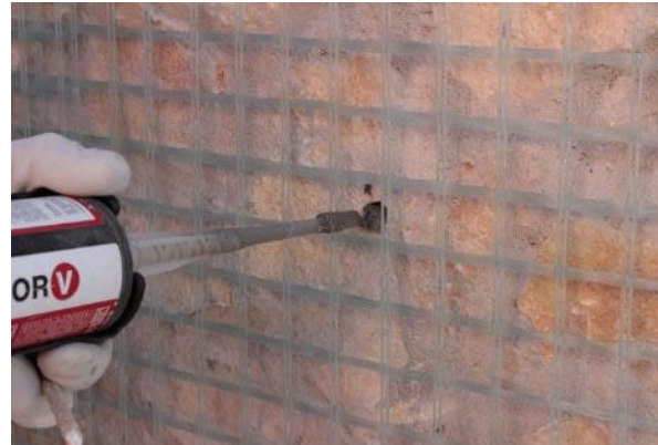
Preenchimento do furo
