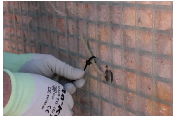
Fixação da rede
