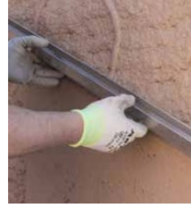
Passagem com régua e talocha
