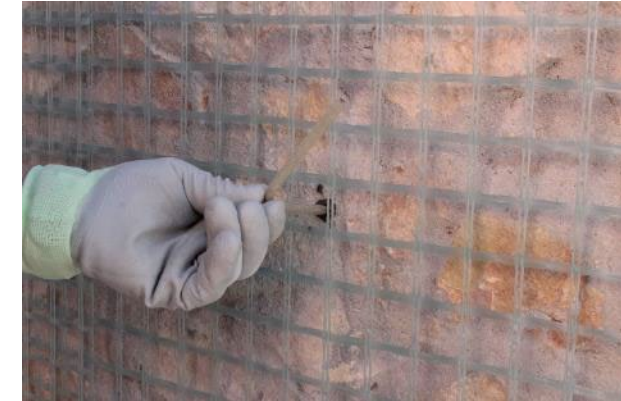
Colocação do conetor
