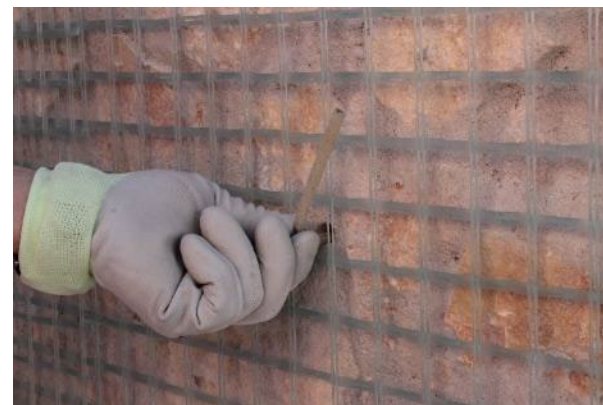
Colocação do conector
