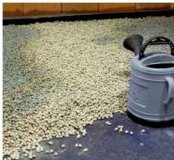
2 Rega superficial com aguada de cimento.
