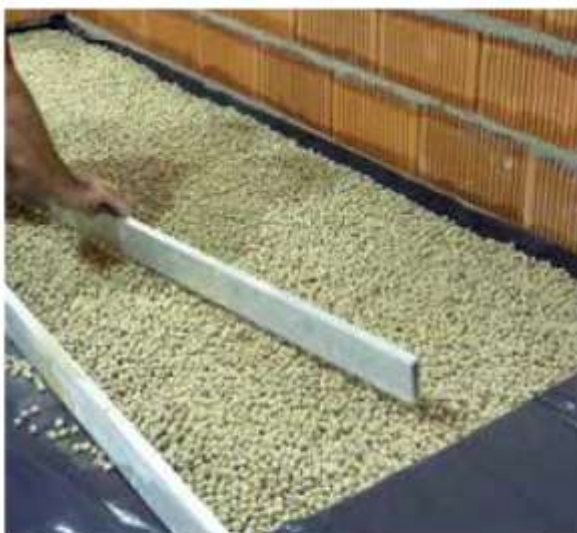
1 Enchimento e nivelamento com argila expandida Nexclay seca.
