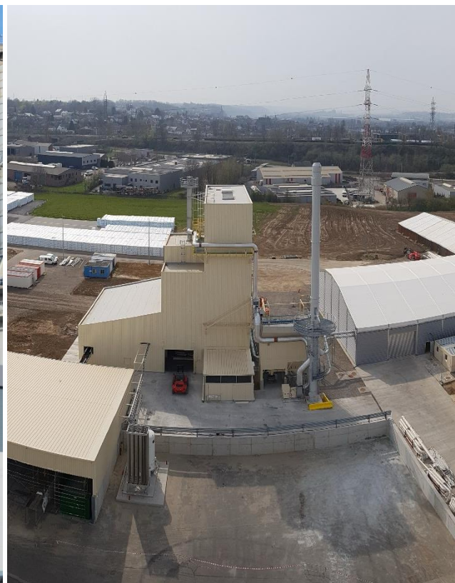
Instalação RESULATION Visé, Bélgica
