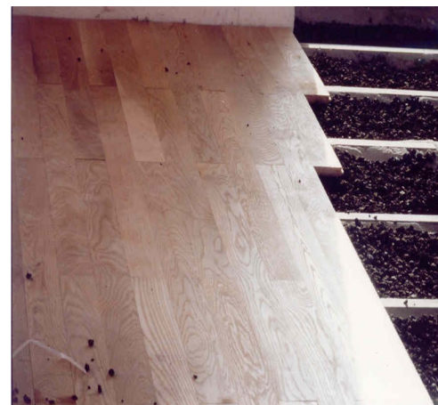
Enchimento de caixas de soalho
