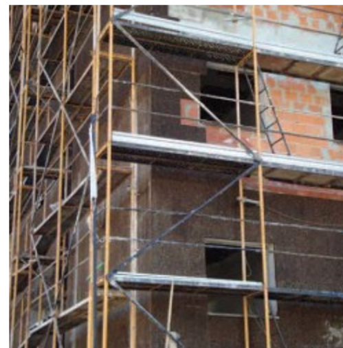
Edifício habitacional Santarém
