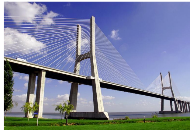
Ponte Vasco da Gama Obras de arte
